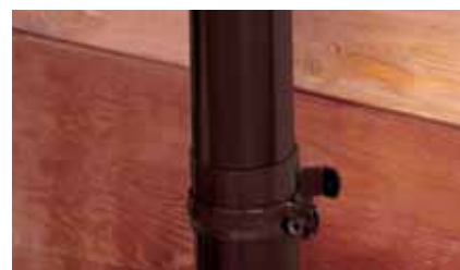
Рис.23 Монтаж хомута к стене из дерева или металла
