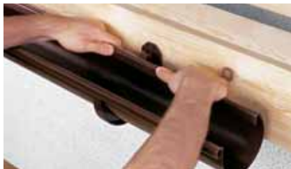
Рис.10 Монтаж вкладки в муфту желоба
