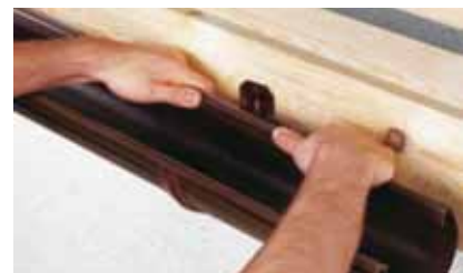
Рис.9 Монтаж муфты желоба
