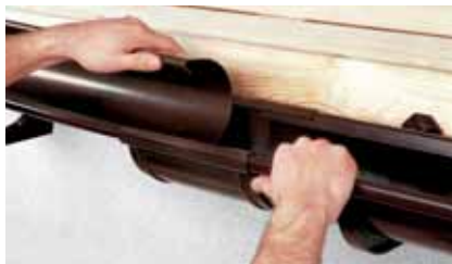
Рис.11 Разметка места под воронку
