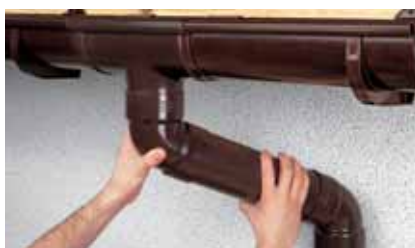
Рис.19 Монтаж стояка с отводами и трубой
