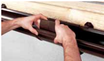
Рис.12 Вырезание отверстия под воронку
