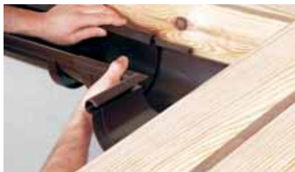
Рис.14 Монтаж угольников желоба
