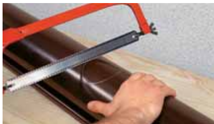
Рис.14 Монтаж угольников желоба
