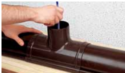
Рис.13 Установленная водосточная воронка
